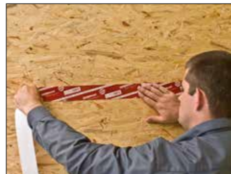
10. Fugen und Stöße von OSB-Platten können mit dem SUPERFORTE-Klebeband luftdicht abgeklebt werden. Das SUPERFORTE-Klebeband ist auch für alle Folienverklebungen und Anschlüsse an Durchdringungen geeignet.
