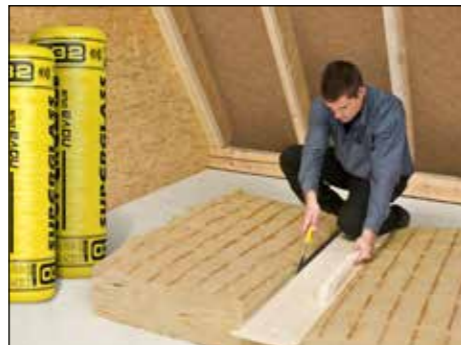
2. Einige Rollen Dämmung aufschneiden, hinstellen bzw. kurz anheben und wieder fallen lassen, damit sich das Material vor dem Einbauen „entpufft“. Zuschnitt quer zur Rolle mit Unterlage, Dämmstoffmesser und Schneidebrett.
