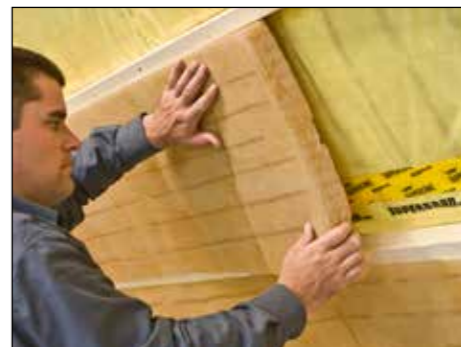
11. In die Unterkonstruktion als Zusatzdämmung den SUPERGLASS-UNTERSPPARENKLEMMFILZ KF 5/V – 032 DUO fugendicht einpassen. Das erzielt eine um bis zu 30 % verbesserte Dämmwirkung der Konstruktion.
