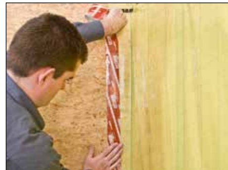
9. Im Holzrahmenbau kann die Dampfbremsfolie spannungsfrei auf z. B. OSB-Platten mit dem SUPERFORTE-Klebeband an die umliegenden Bauteile wie Giebelwände und Fußpfetten luftdicht angeschlossen werden.
