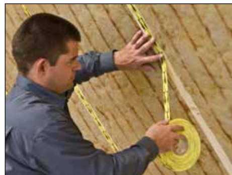
4. Unterkonstruktion mit dunklem Stift auf der „Aufdoppelung“ anzeichnen, Dampfbremsfolie an diesen Stellen antackern, anschließend einen Streifen Nageldichtband (z. B. ISOVER VARIO ANTISPIKE) aufkleben und Querlattung montieren.
