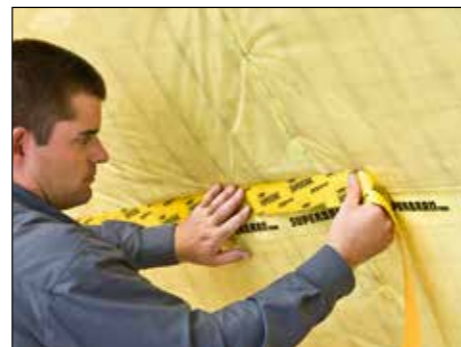
6. Folienüberlappungen der Dampfbremsfolie mit den Klebebändern SUPERCAL oder SUPERFORTE spannungsfrei und luftdicht verkleben. Staubablagerungen vorher mit einem Tuch abwischen.
