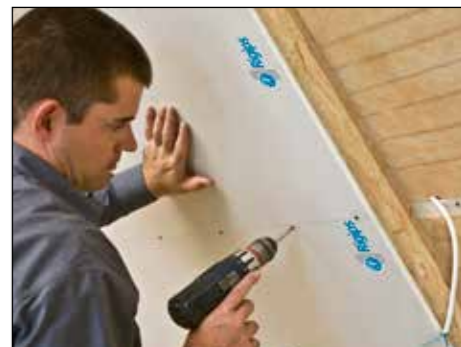
12. Abschließend die Innenverkleidung aus OSB- und Gipskartonplatten auf die Installationsebene montieren. Dabei ist darauf zu achten, dass die Platten mit versetzten Stößen angeordnet und Kreuzfugen vermieden werden.
